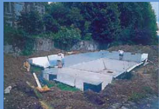
4. Pose de la structure Pooline. Mise en place des jambes de force et des pièces à sceller
